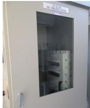
รูปที่ 3-2 เครื่องตรวจวัดความเข้มข้นของมลพิษ ทางอากาศอย่างต่อเนื่อง (CEMS)
