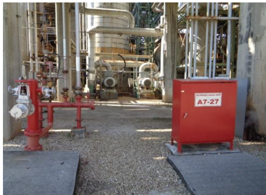
รูปที่ 3-41 Water Hydrant and Hose Box
