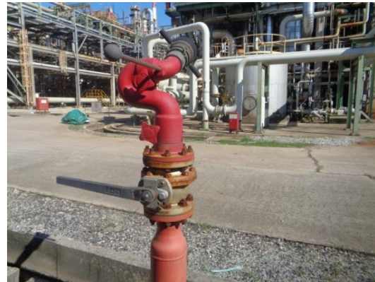
รูปที่ 3-46 Fixed Water Monitor
