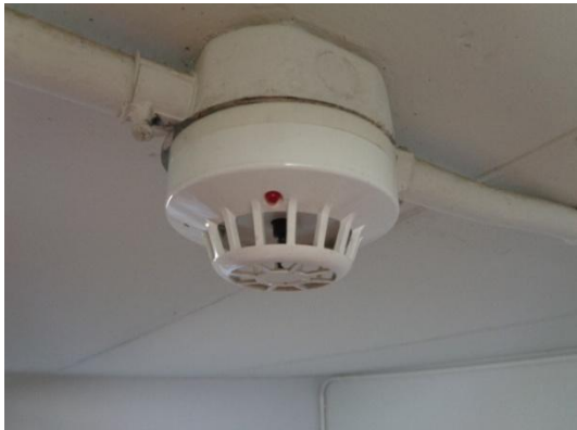
รูปที่ 3-39 Heat Detector
