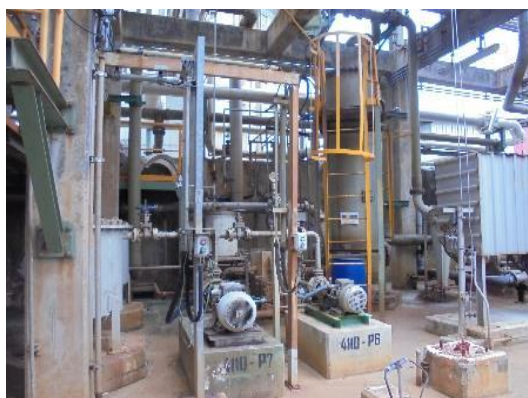
รูปที่ 3-5 ระบบกำจัดกลิ่นกำมะถัน (Sulfur Scrubber 4110-S1)
