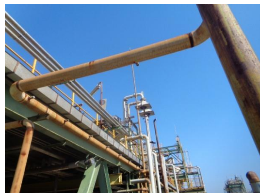
รูปที่ 3-44 Water Curtain System
