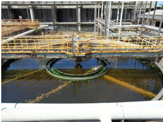
รูปที่ 3-14 Flocculation & Sedimentation
