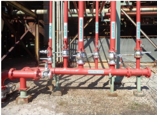
รูปที่ 3-45 Fixed Water Suppression System
