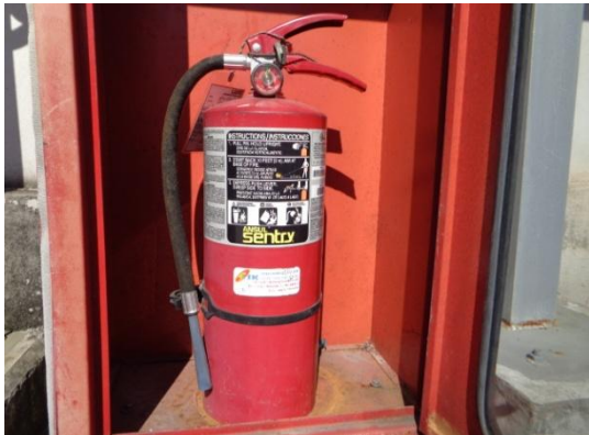
รูปที่ 3-51 Portable Fire Extinguisher
