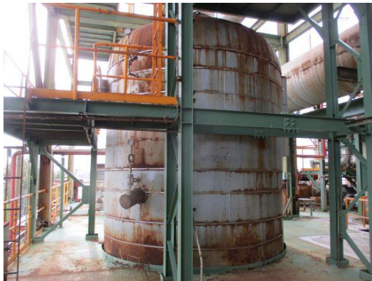
รูปที่ 3-1 Waste Gas Treatment Off Gas เพื่อบำบัด \text{NO}_x
