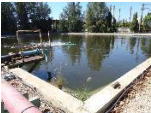
รูปที่ 3-22 Final Check Basin ขนาด 3,300 ลูกบาศก์เมตร
