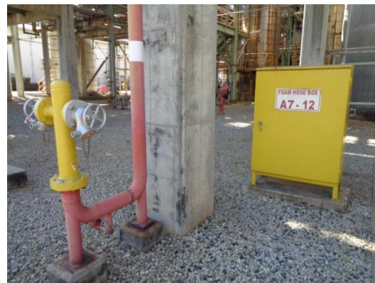
รูปที่ 3-48 Foam Hydrant
