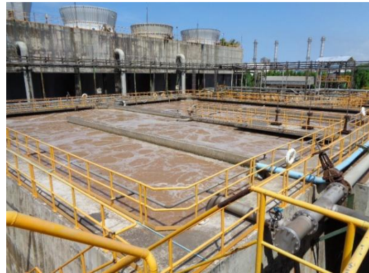
รูปที่ 3-13 Activated Sludge System
