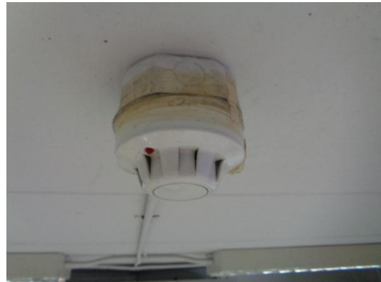
รูปที่ 3-40 Smoke Detector
