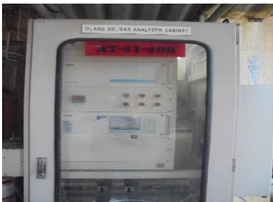
รูปที่ 3-3 ระบบควบคุมกำมะถัน (4140-C6)
